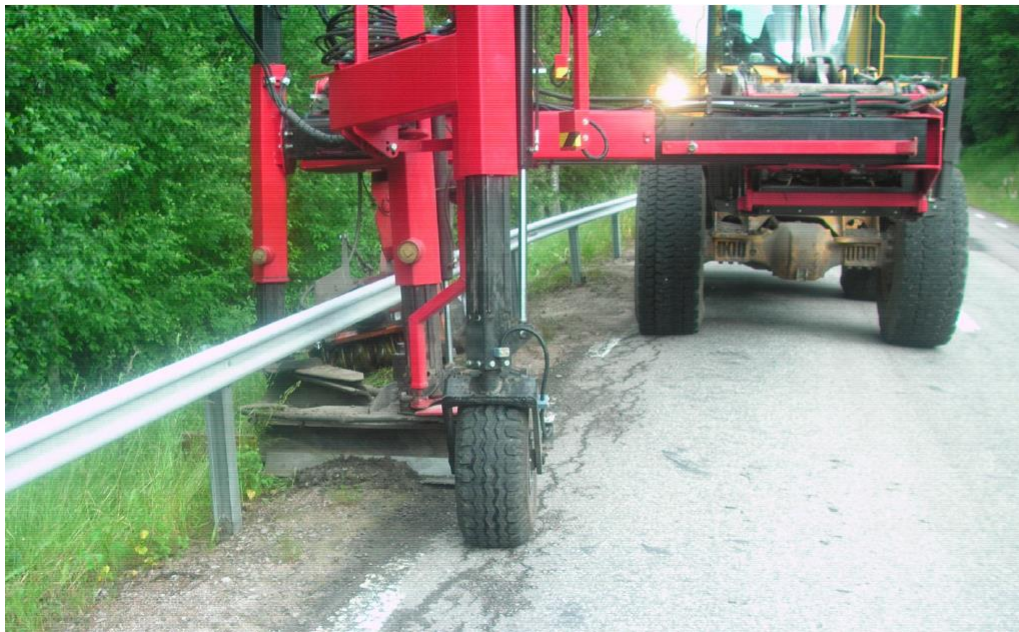
Bild 1, Kantskärning med vägkantshyvel under räcke med sigmaständare.
