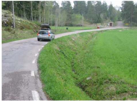
Bild 4a Ett parti med djupt dike och brant vägslänt. Här skulle man kunna rörlägga diket och flacka ut vägslänten med vägdikesmassor.
