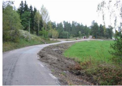
Bild 4b Här har den branta vägslänten flackats ut med ca 200 m 2 vägdikesmassor.
